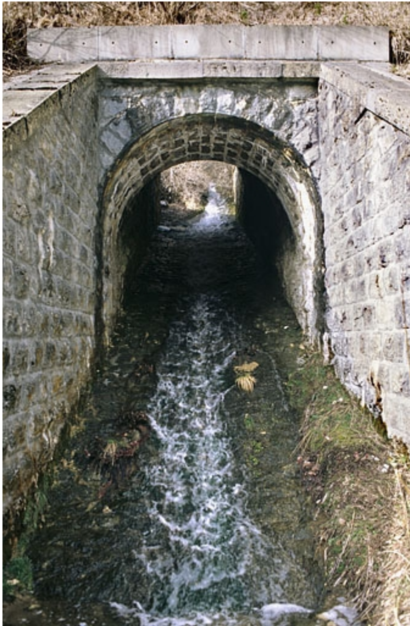
Pont : vue d'ensemble, depuis le sud (aval).
