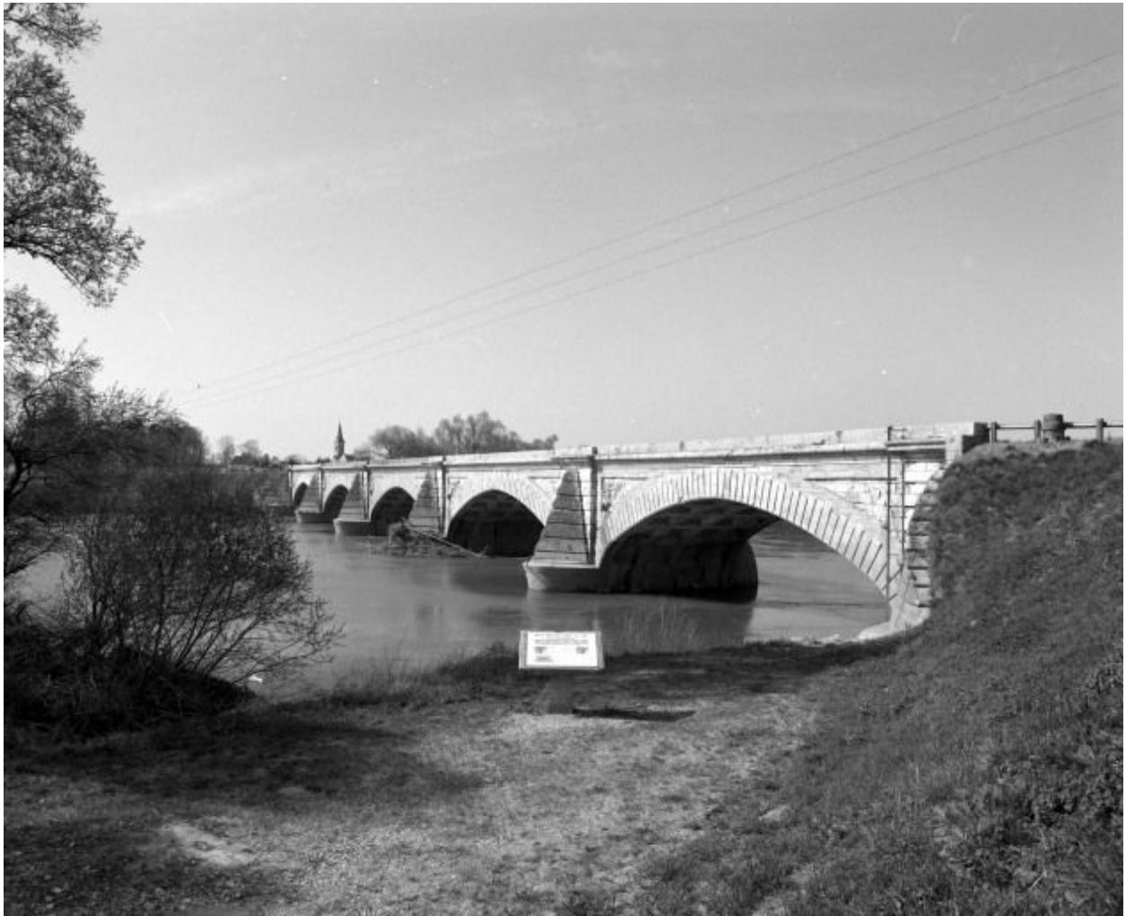
Vue d'ensemble en amont.
