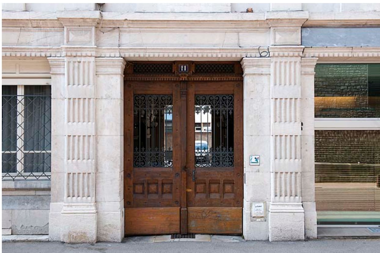
Façade sur rue : détail de l'entrée cochère.
