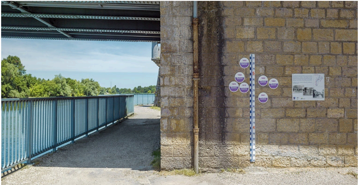
Détail des repères de crues.
