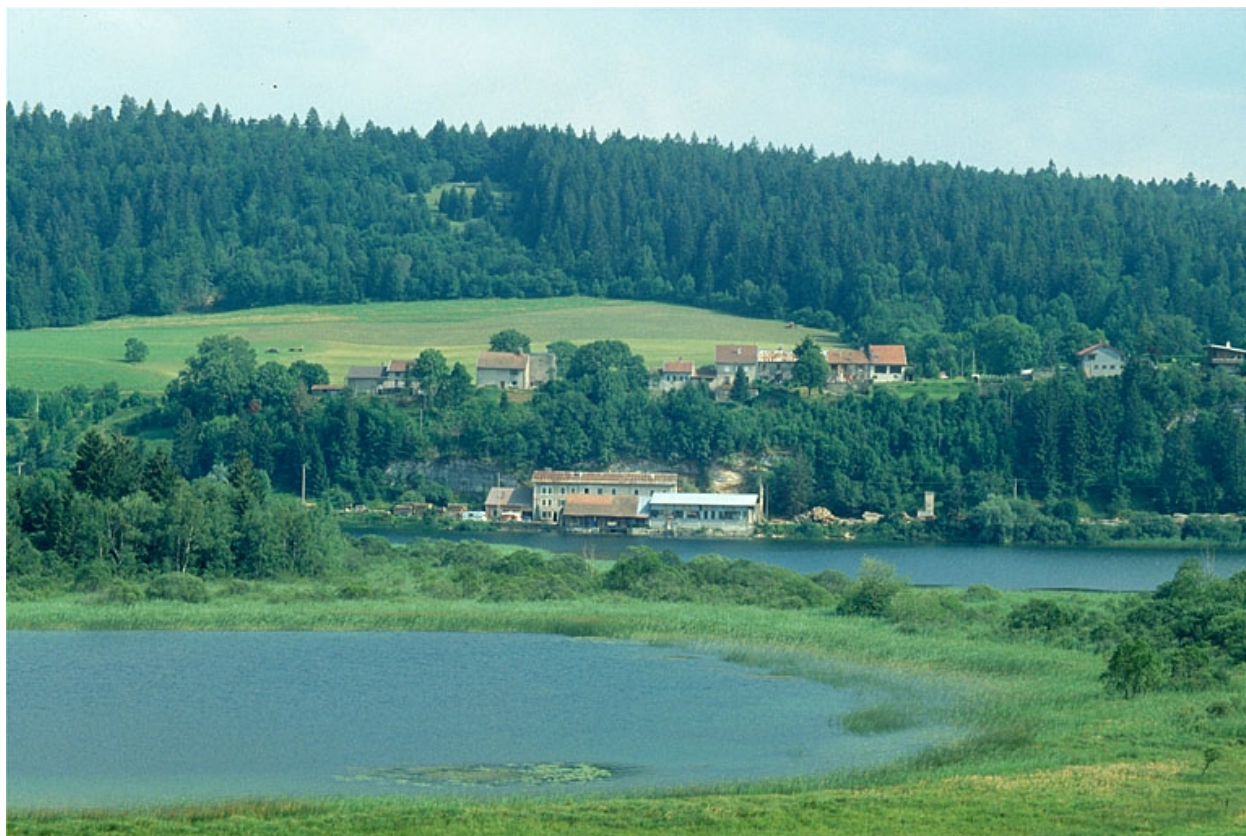
Moulin à blé dit moulin de l'Abbaye, scierie au lieu-dit Sur le Moulin.
