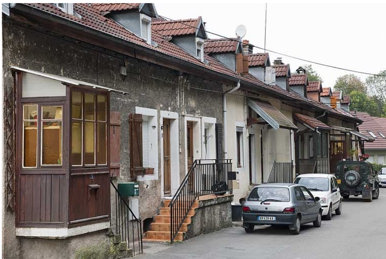
Façade est du logement sud (caserne B).
