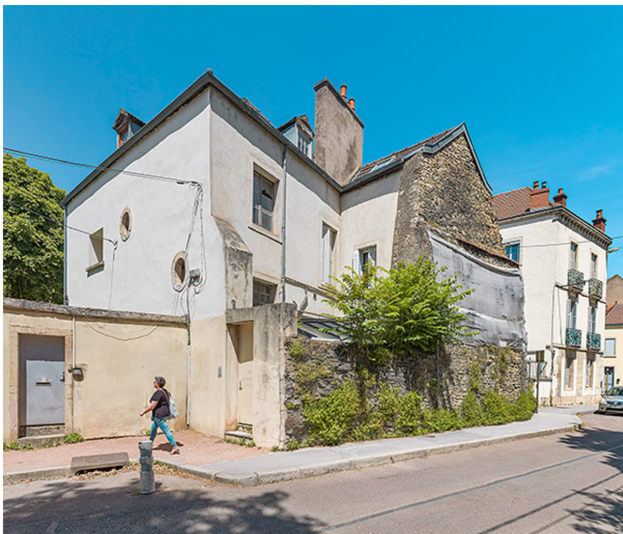
Tronçon du rempart, rue Berlier.
