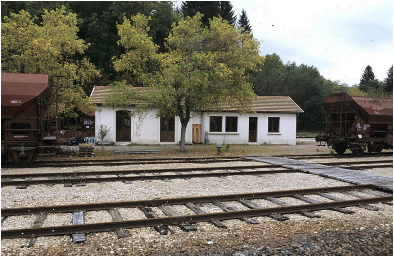
Ancienne lampisterie (bureau des électriciens), de face.
