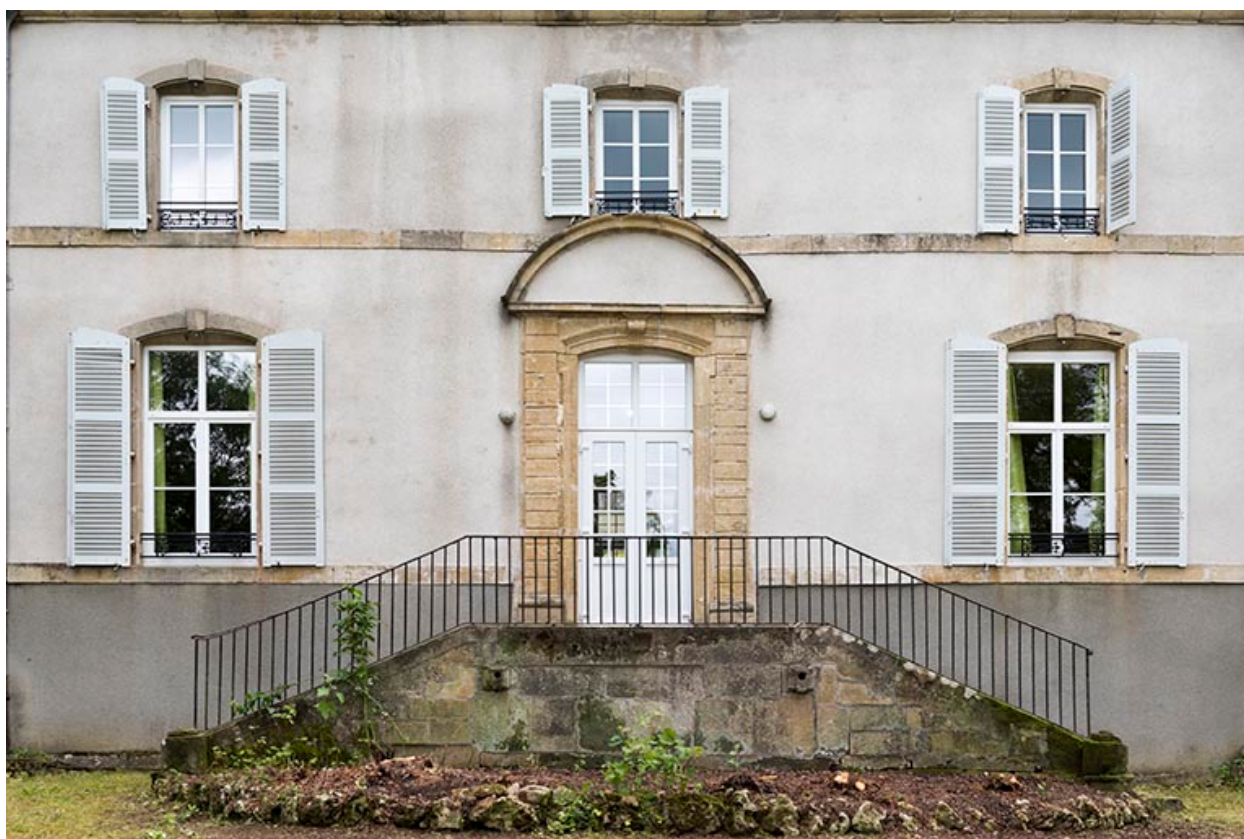
Les travées centrales.
