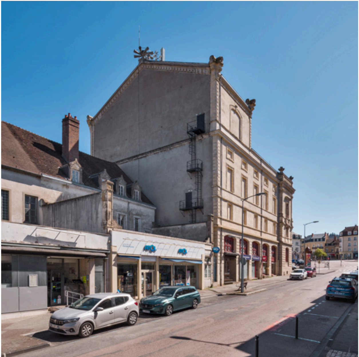
Façades postérieure et latérale gauche (sur l'avenue Charles de Gaulle).
