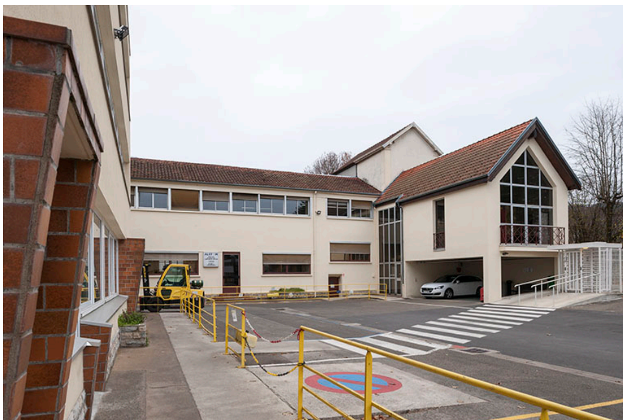
Bâtiments d'entrée (conciergerie et bureaux).
