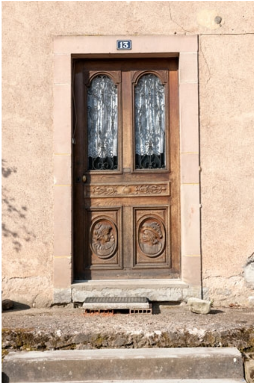
Logis (côté rue) : porte d'entrée.
