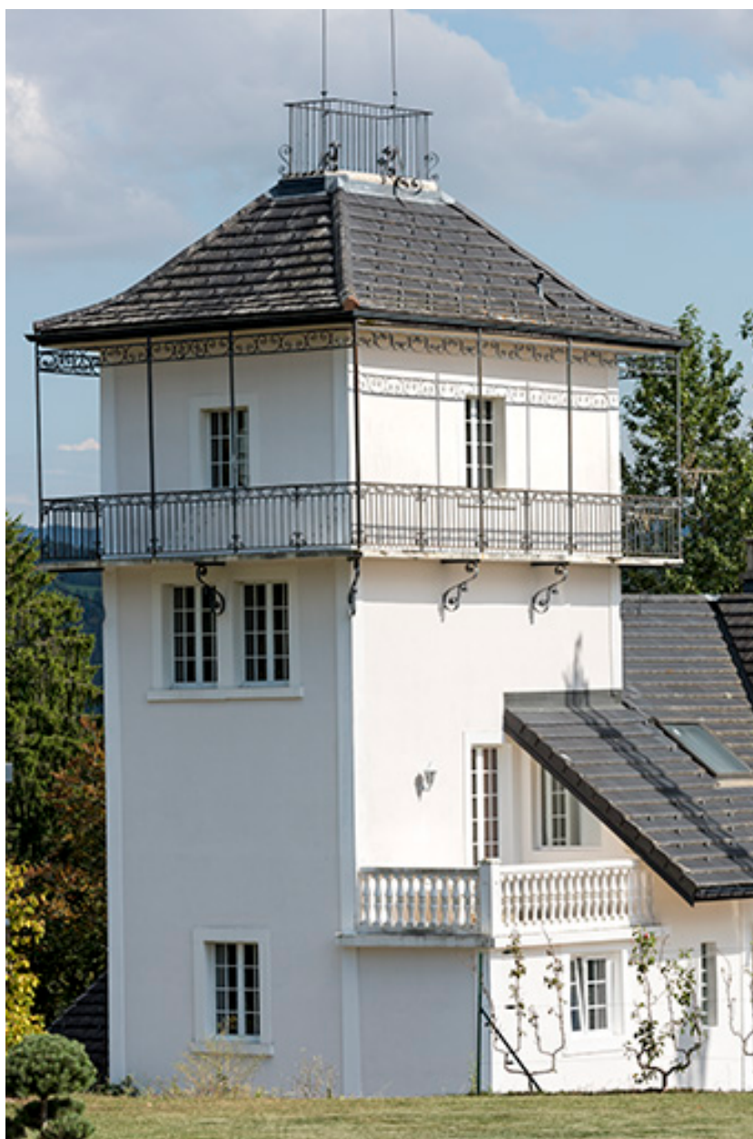
Tour, vue du nord-ouest.
