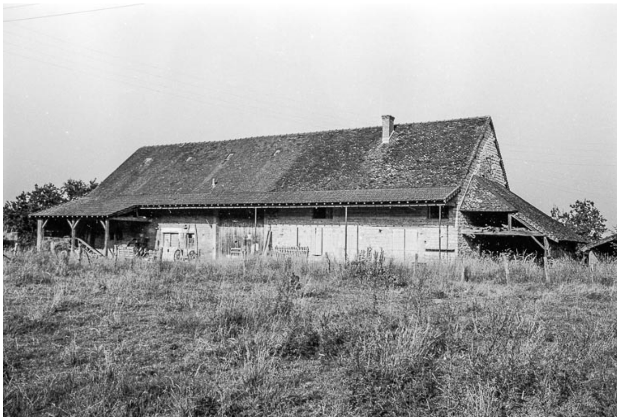
Ferme cadastrée 1956 A2 424 : façade antérieure.
