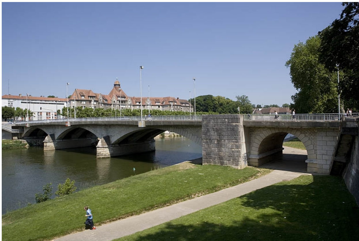
Le pont Canot et le chemin de halage.
