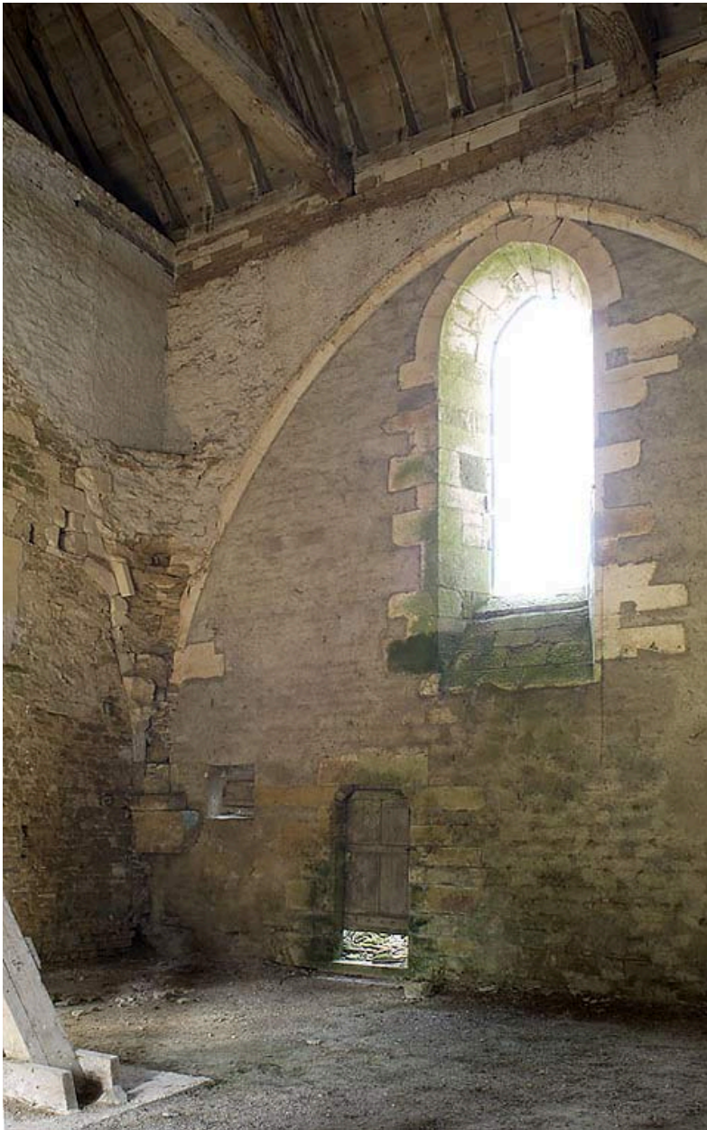
Cellier : rez-de-chaussée, salle nord (vue d'ensemble du mur ouest).
