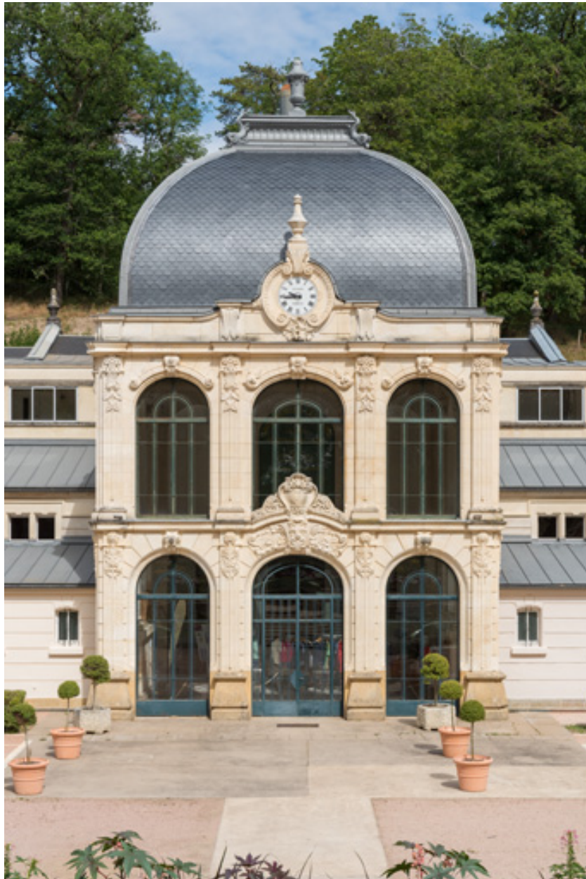
Pavillon central, vue de face.
