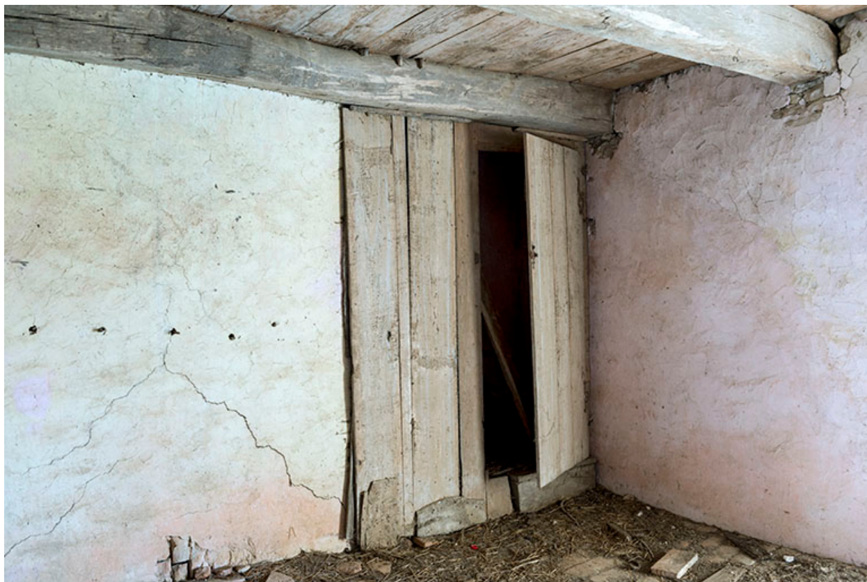
Porte pour accéder à l'étage du pigeonnier.
