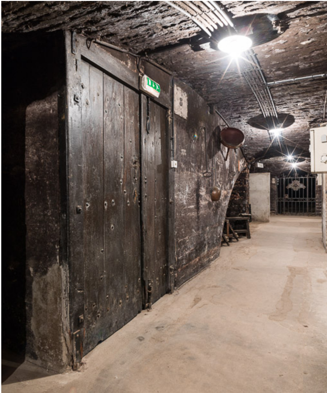
Porte d'accès vers les anciens chais.
