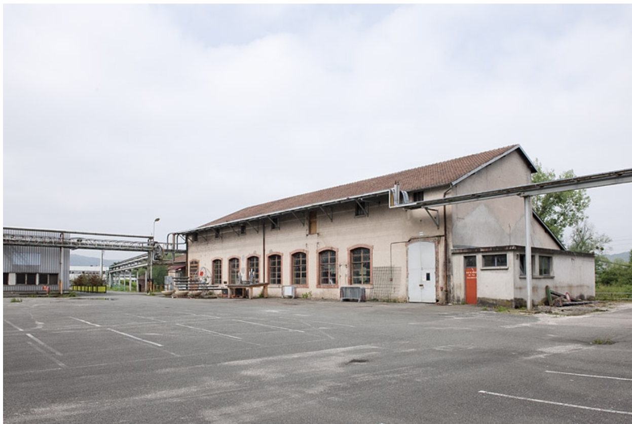
Bâtiment industriel. Vue de trois quarts.
