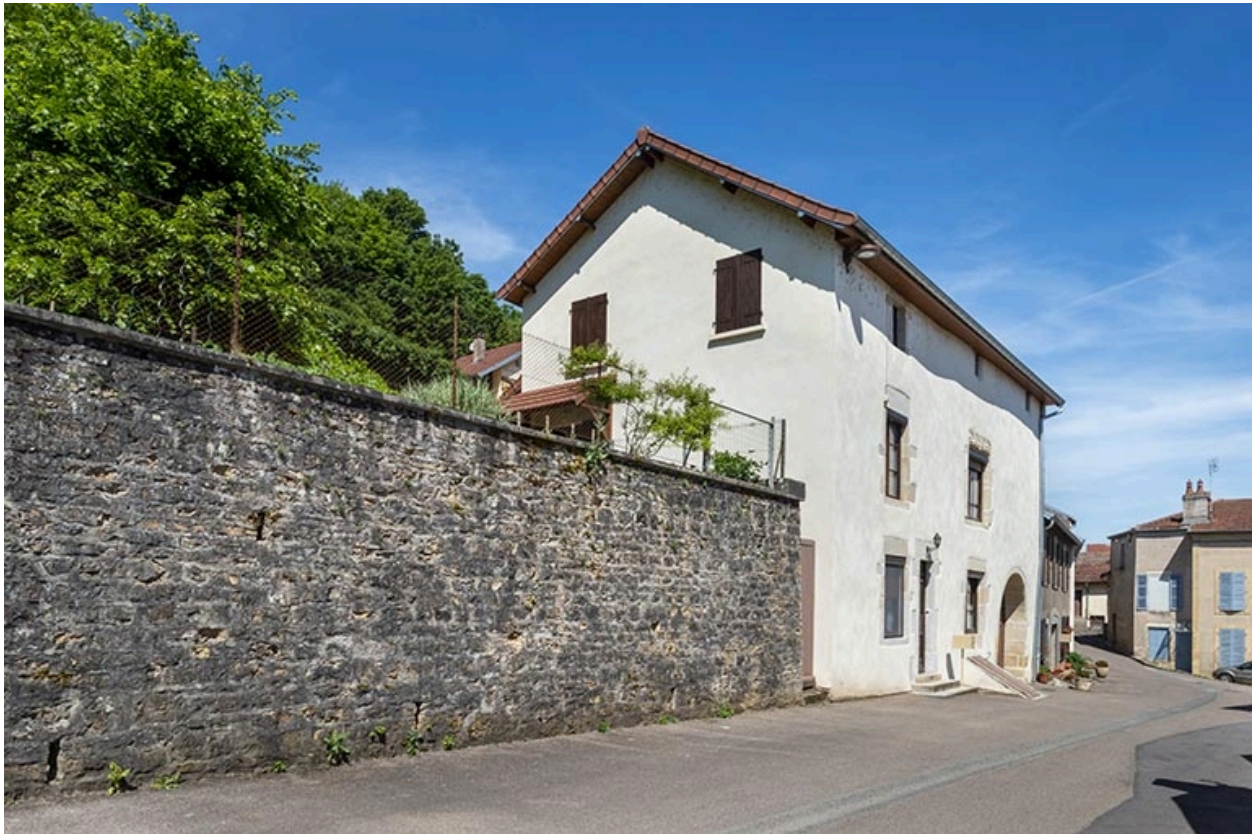
Trois quarts de la façade, du mur de soutènement du jardin et du pignon sud du n° 37.
