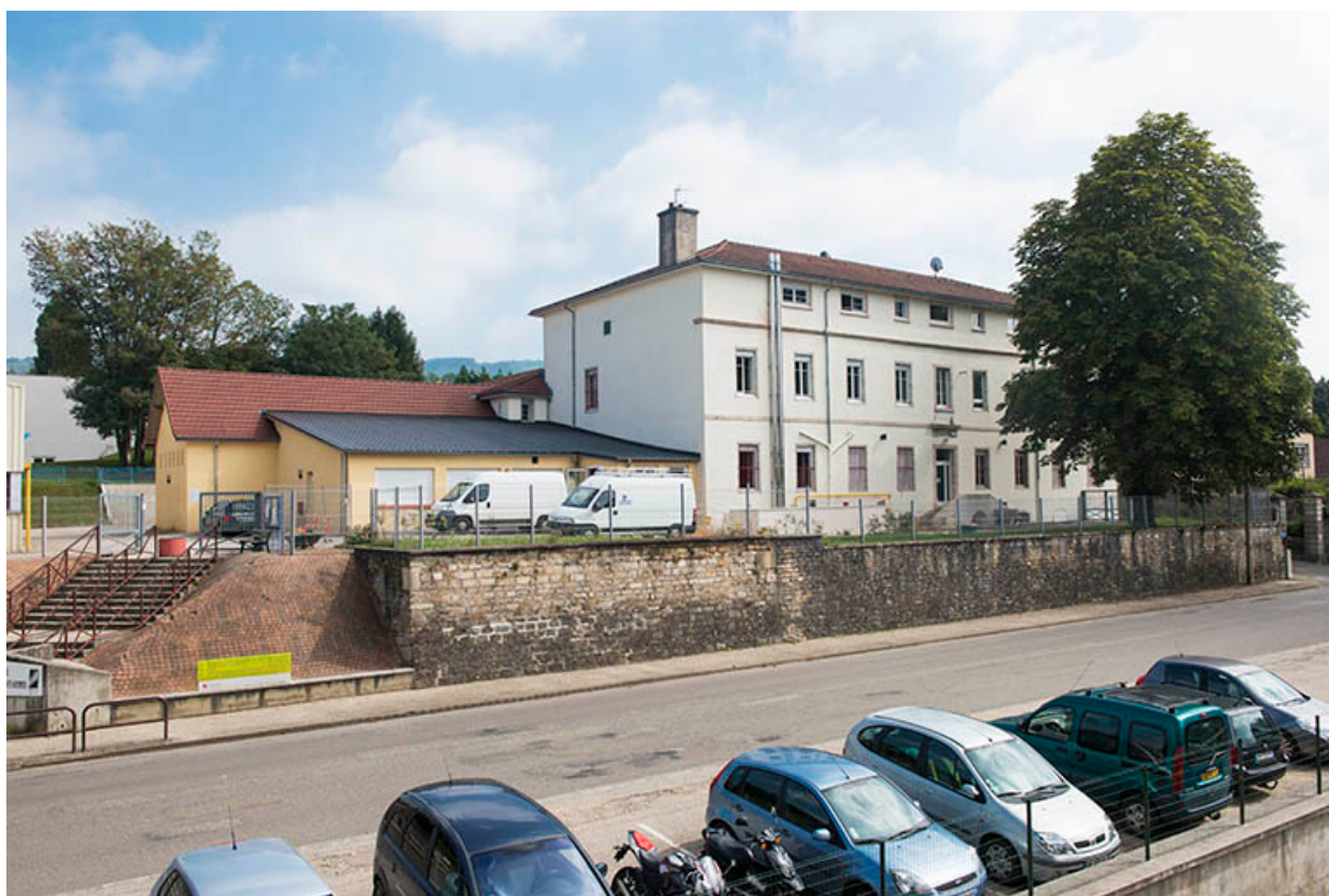
Internat : façade antérieure sur rue Lamartine.
