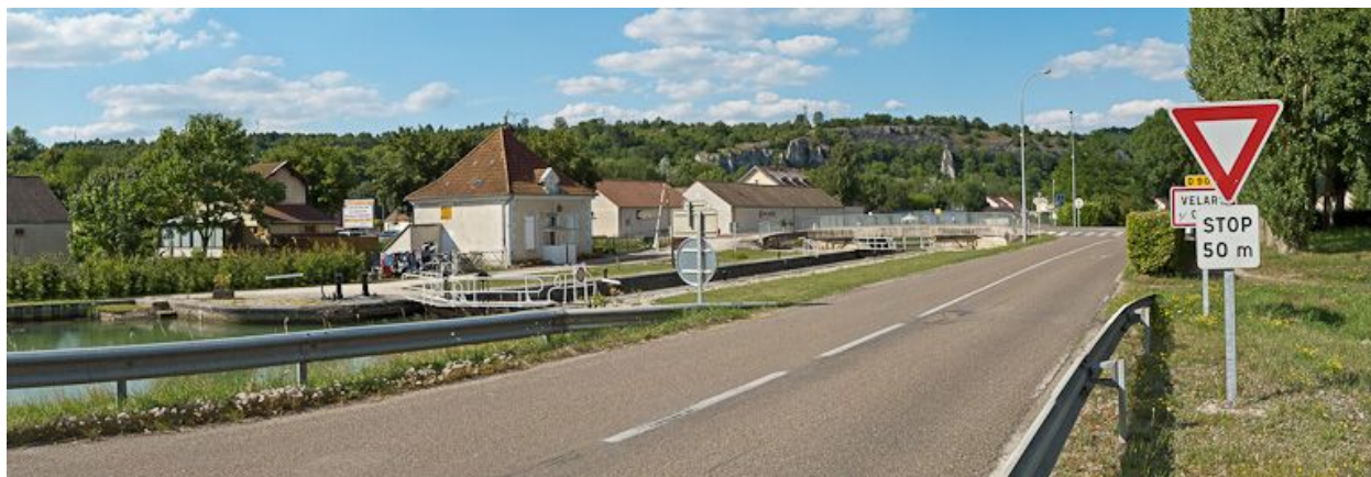
Vue d'ensemble du site d'écluse.
