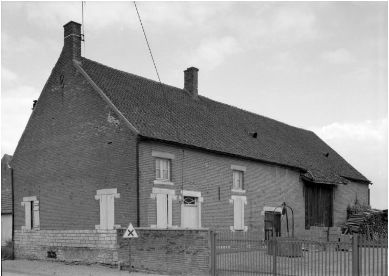
Vue d'ensemble de la ferme (cad. 1984, sect. AC, parc. 176).
