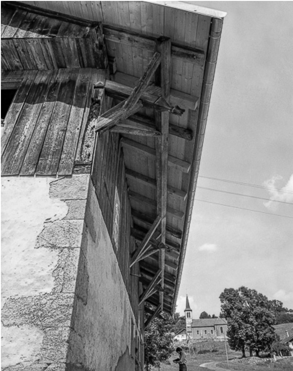
Ferme située au lieu-dit Le Pissoux : extrémité des arbalétriers.
