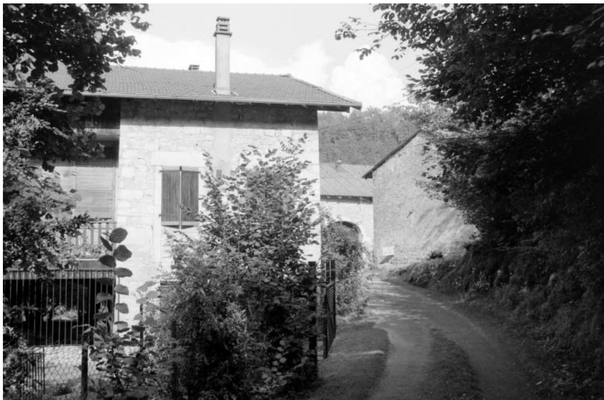
Entrée du site.
