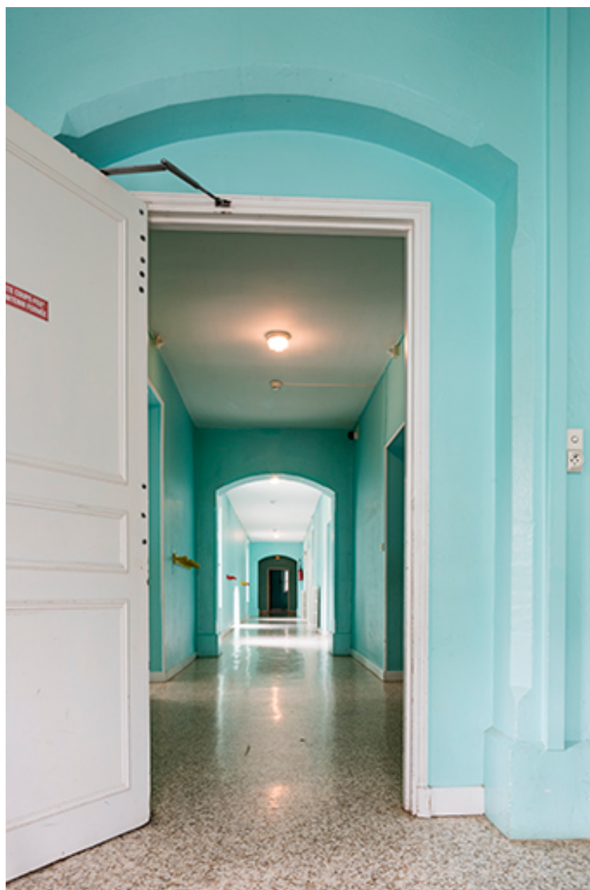
le couloir, premier étage.
