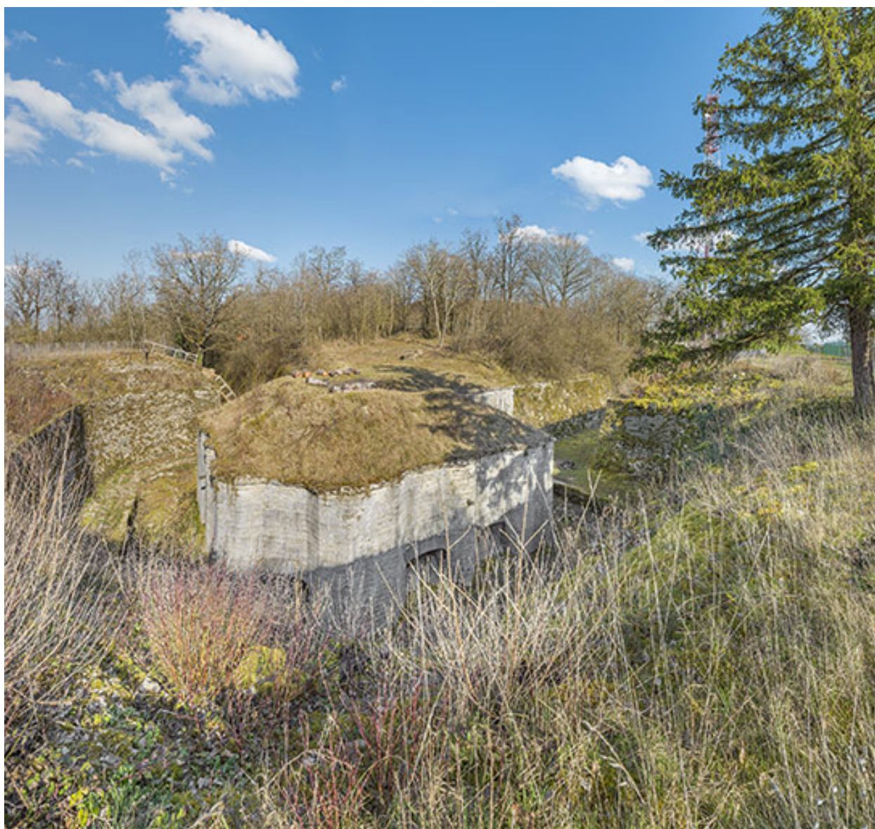
Vue de la caponnière depuis la contrescarpe.
