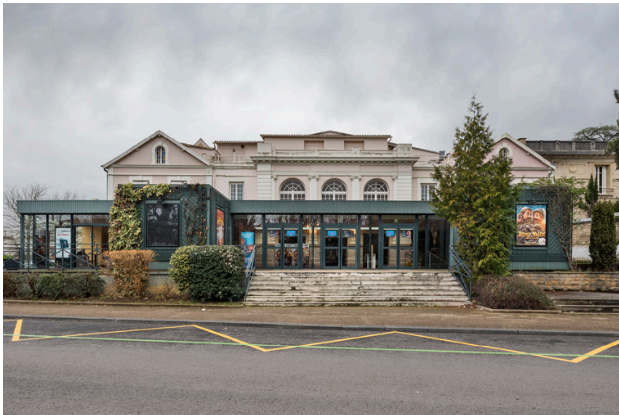
Grand Casino Auxerrois, actuellement cinéma CGR, Auxerre : façade sur le boulevard du 11 Novembre.
