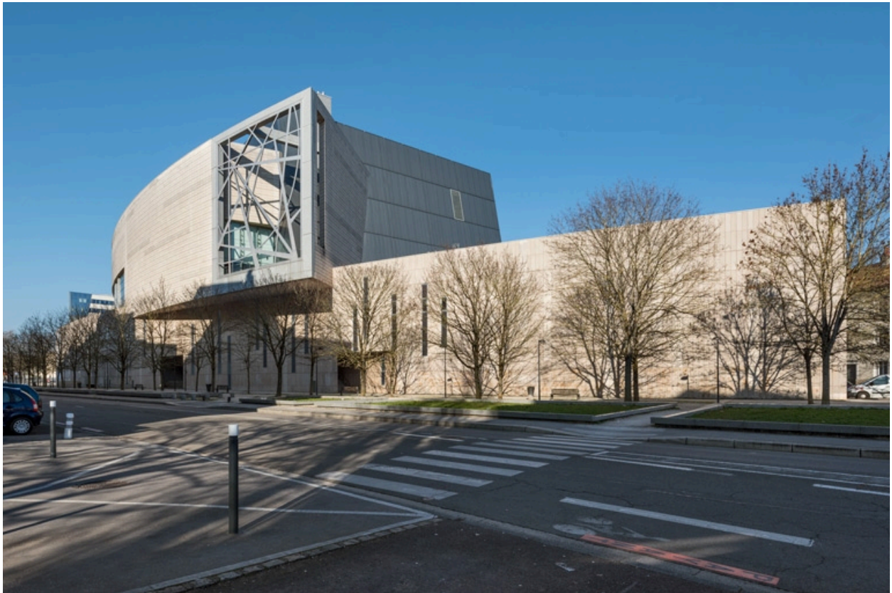
Vue d'ensemble, depuis le sud.
