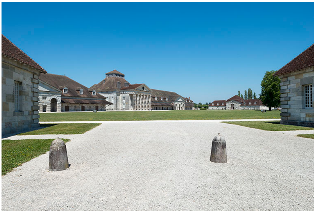
Vue d'ensemble depuis le mur sud.
