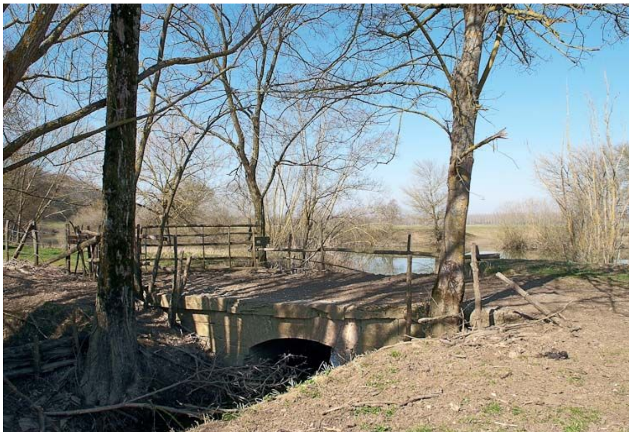
Ponceau : vue rapprochée.
