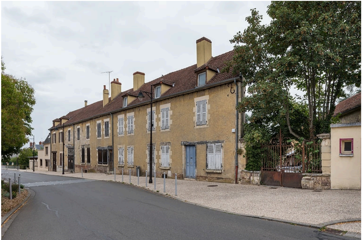
Façade sur l'avenue de Paris, vue depuis le sud-est.
