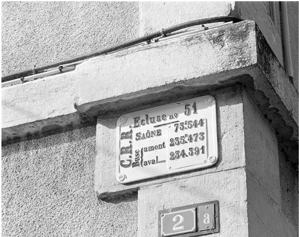
Plaque d'identification de l'écluse.
