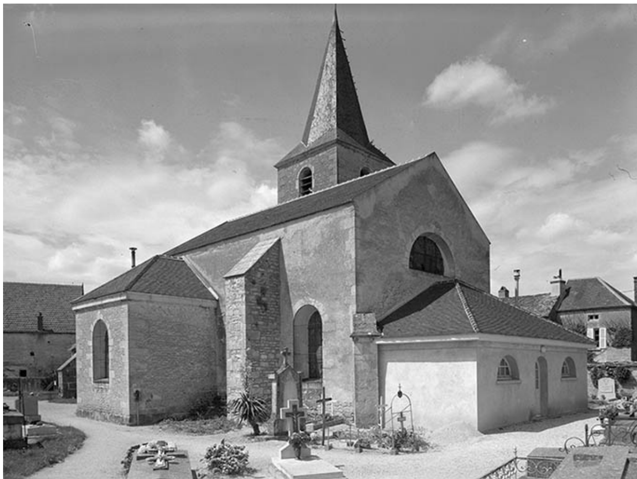
Façade sud et chevet
