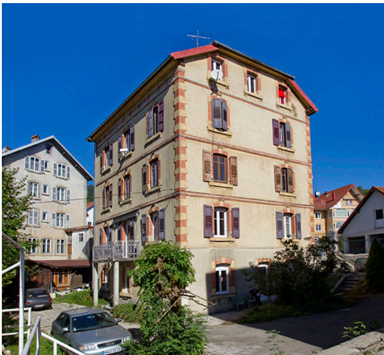
Façades postérieure et latérale gauche.
