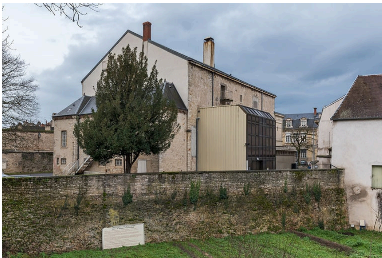
Façades postérieure et latérale gauche.
