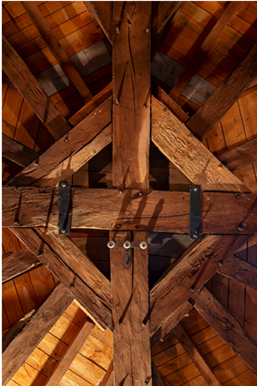
Charpente du dôme. Enrayure centrale.
