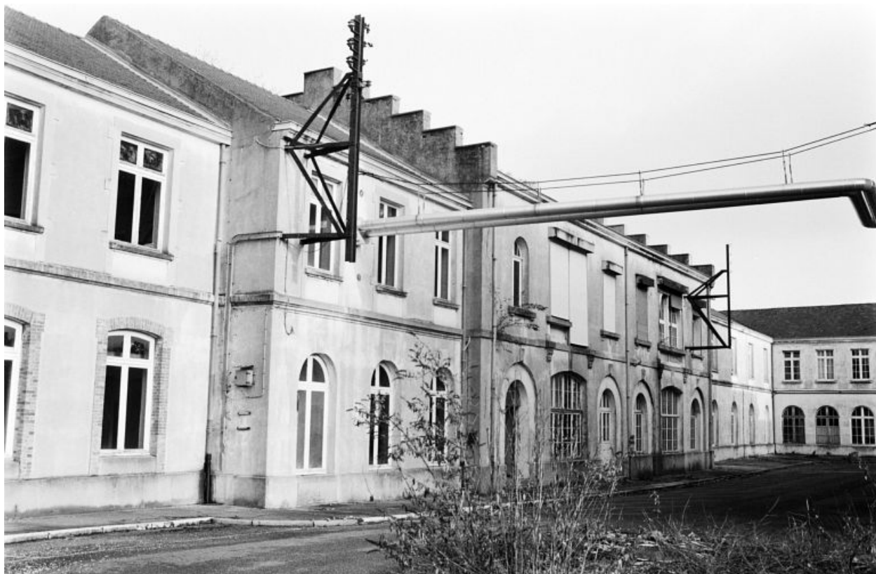
Anciens magasins 3 et 4 et atelier de réparation de 1865.
