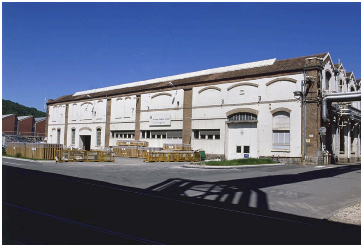
Façade sud de l'ancien atelier de grosse construction.
