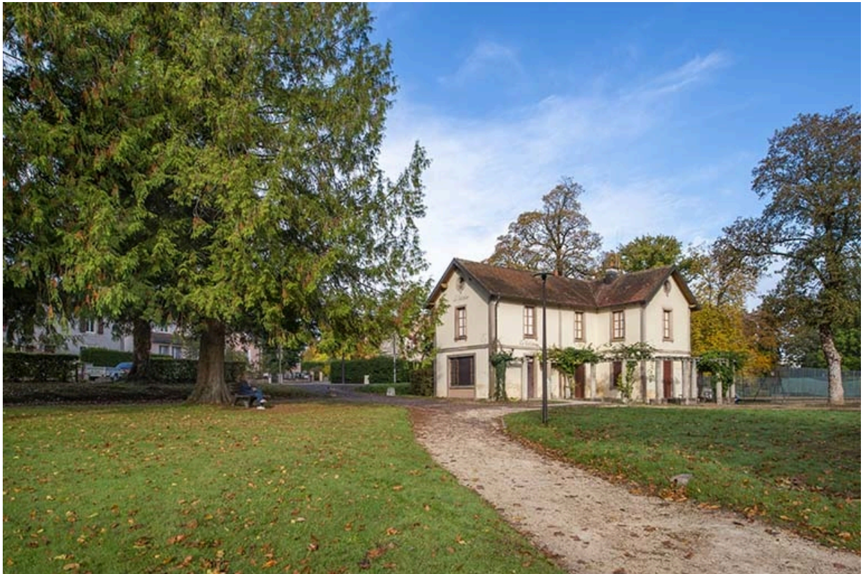
Situation de l'édifice, en bordure du parc thermal.
