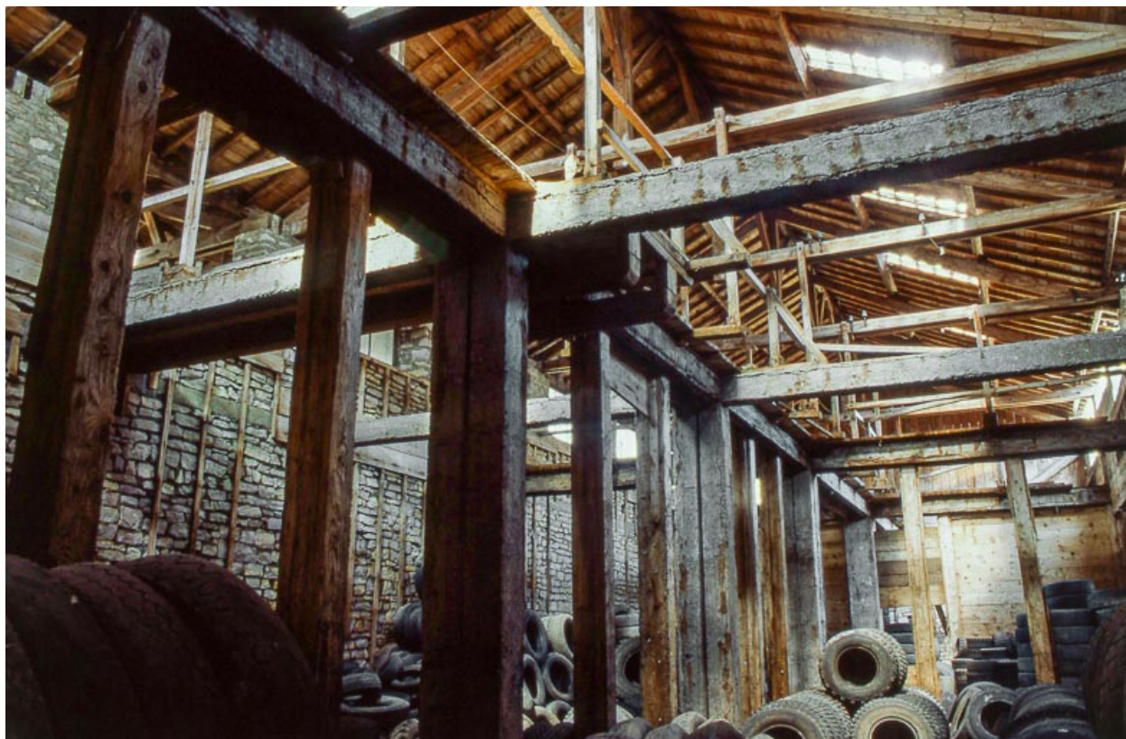
Intérieur d'un magasin industriel.
