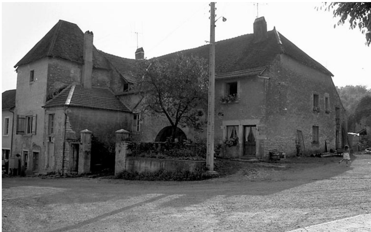
Beaumotte-lès-Pin : demeure située rue de l'Eglise.
