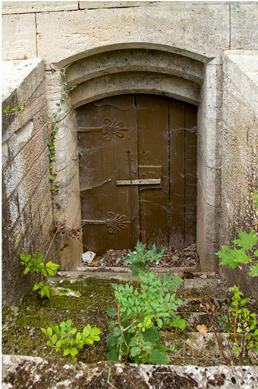
Détail : porte conduisant au sous-sol.
