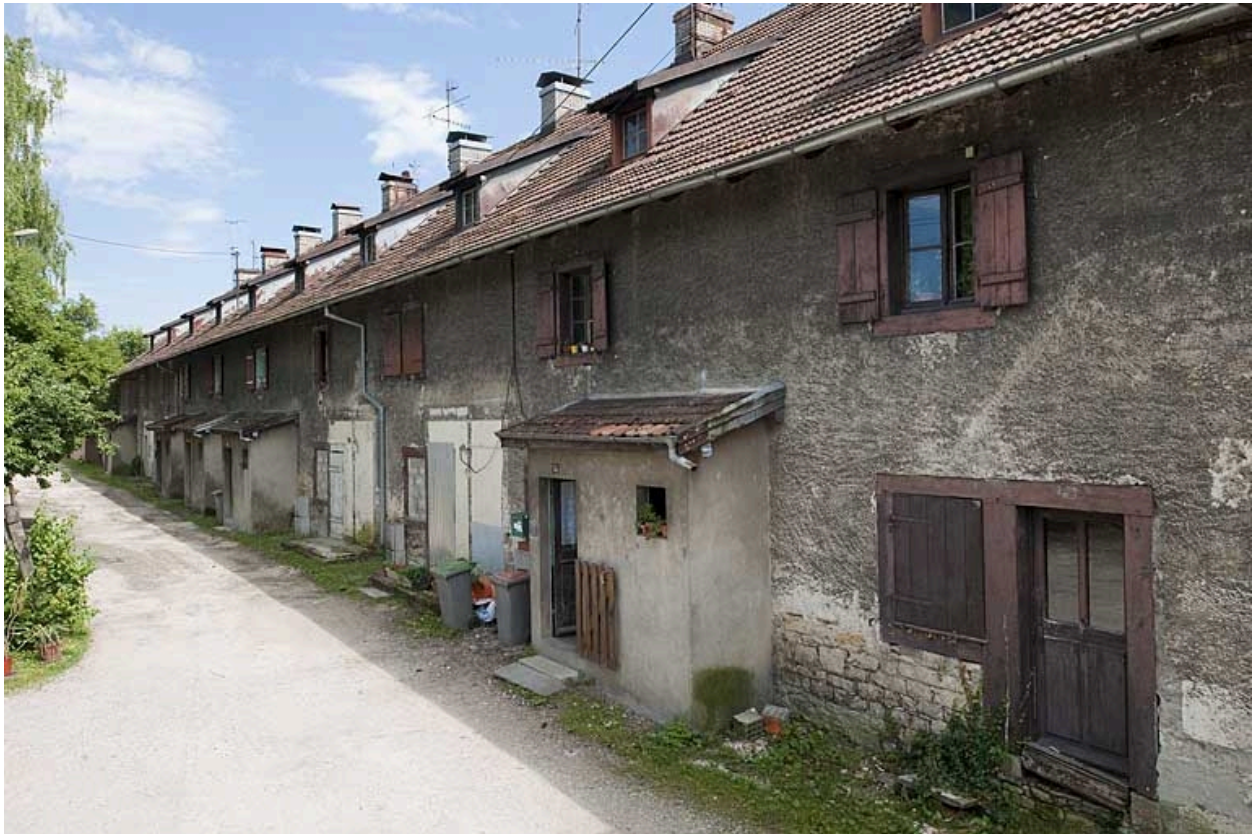
Cité ouvrière dite "du Magasin". Façade nord.
