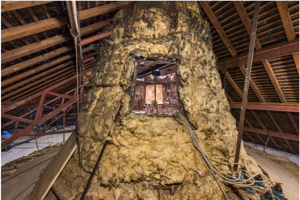
Comble de la salle : cheminée d'aération.
