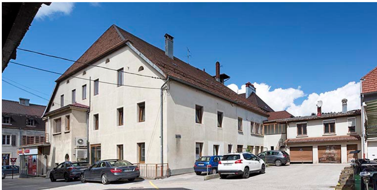
Maison : façades latérale droite et postérieure.
