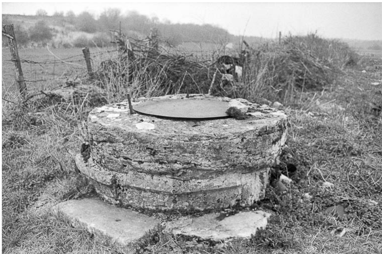
Puits dit puits "romain".
