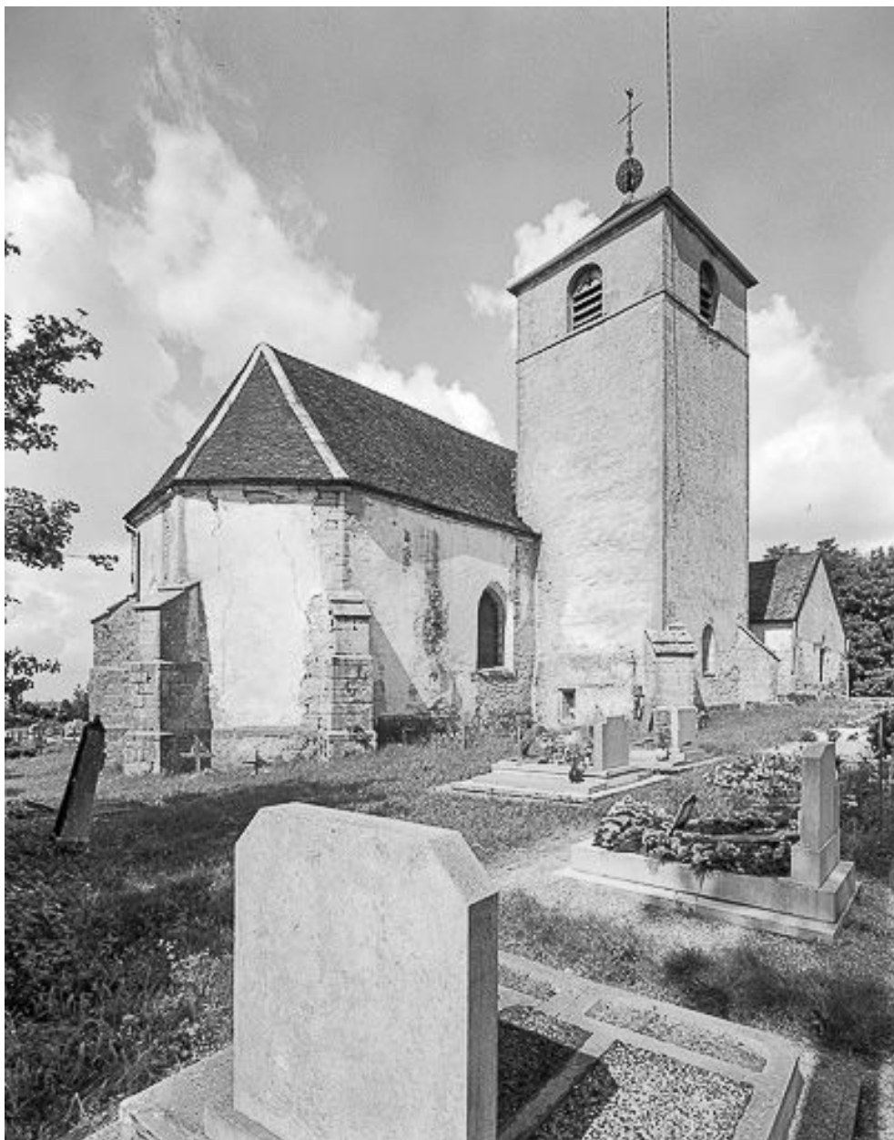
Façade latérale gauche vue depuis l'est.
