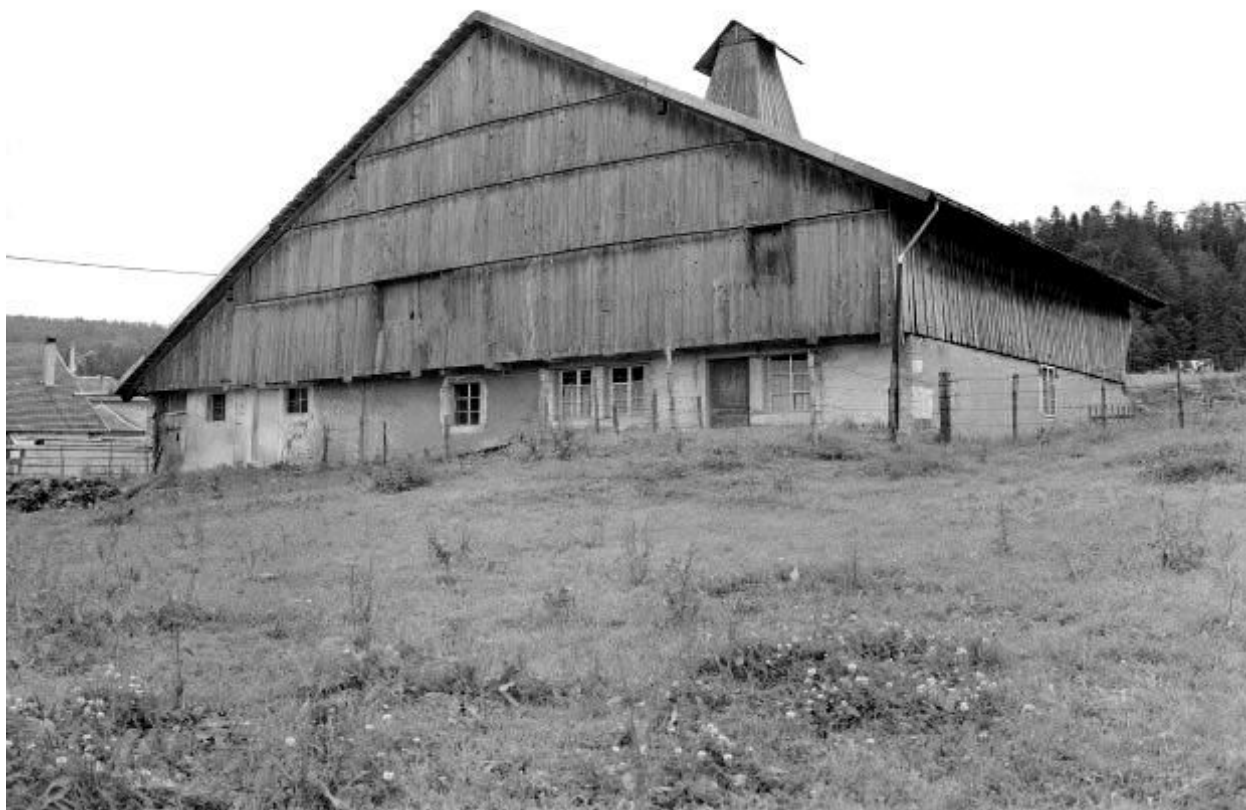
Façades postérieure et latérale gauche.
